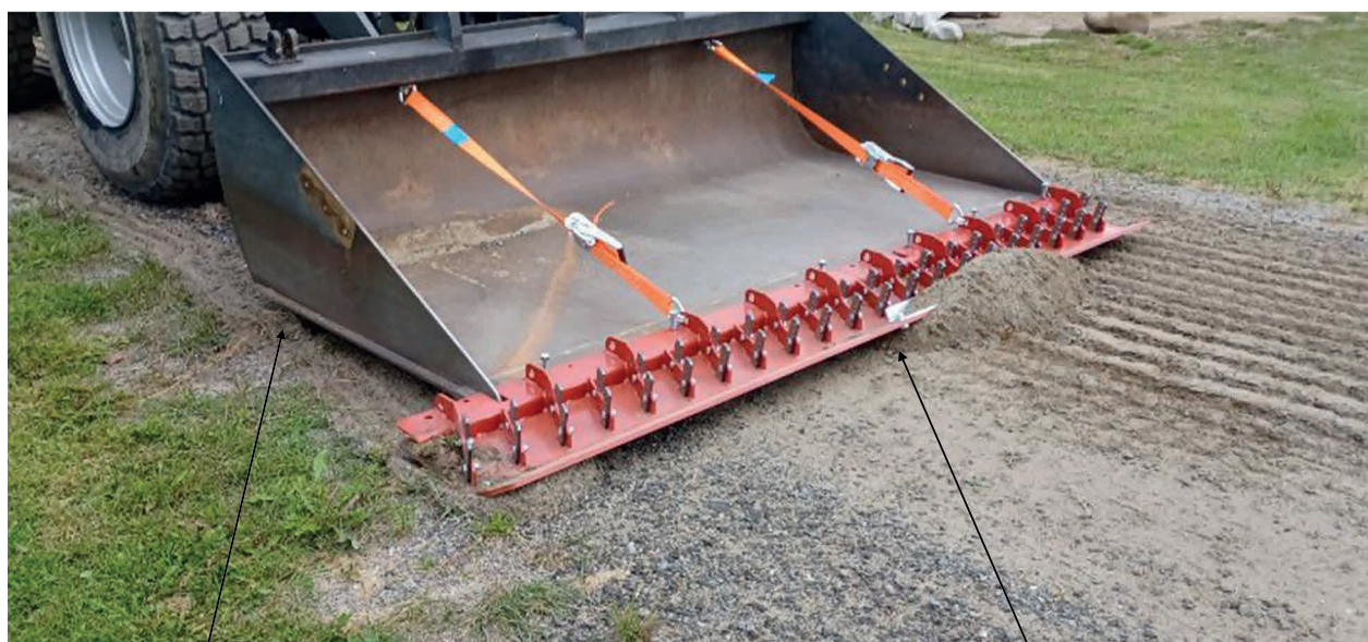
Tillplattning med bakkant av skopa
